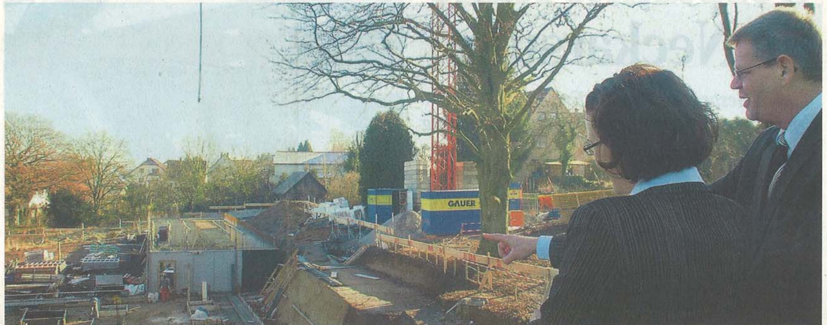
Hier entsteht der Anbau des Altenstifts mit einer Wohngruppe für Demenzkranke: Jürgen Link und Meike Gärtner besichtigten die Baustelle.
