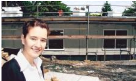
Heimleiterin Meike Gärtner vor dem Erweiterungsbau. Er soll Ende 2008 fertig gestellt sein. 25 Plätze werden hier entstehen. Fotos: Petra Halamoda
