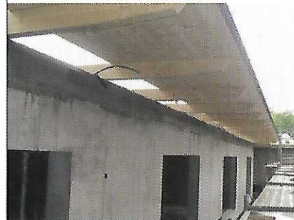
13.06.2008 Holzkonstruktion Dachrand
