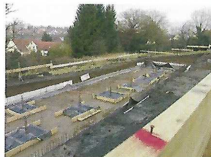
09.01.2008 Fundamente und Bewehrung Ostseite
