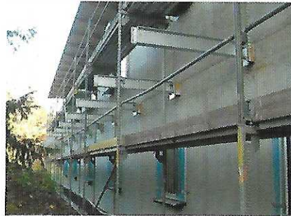
05.11.2008 Montage Träger der Fluchtbalkone
