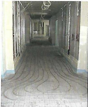
26.09.2008 Einbau Fußbodenheizung
