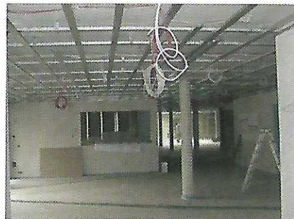
28.10.2008 Einbau abgehängte Decke
