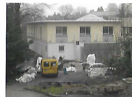
11.12.2008 Abbau des Außengerüsts
