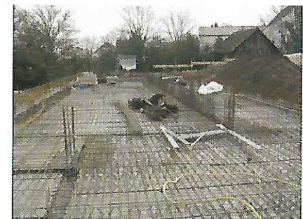
22.02.2008 Decke über 2. UG wird betoniert
