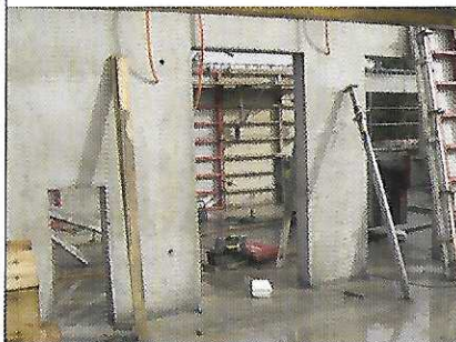
11.04.2008 Tragende Wände und Aussparungen
