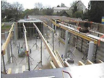
21.04.2008 Dach wird betoniert
