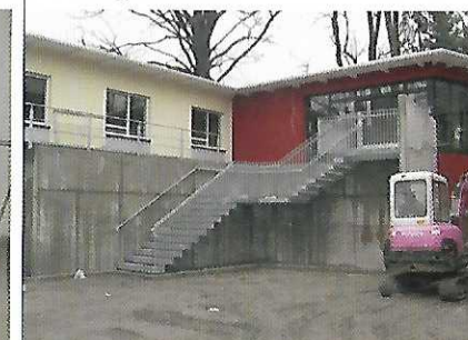
18.12.2008 Zugangstreppe Nord ist fertig montiert
