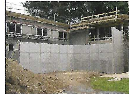
18.07.2008 Stützwände Treppe Nord Fertigstellung
