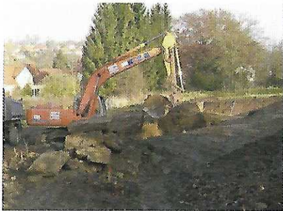
27.11.2007 Baugrubenaushub
